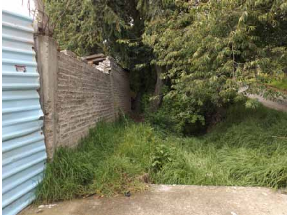
Figura VII.40. Sección izquierda de la barranca donde se puede observar en uno de sus flancos una cimentación, que se conecta con una vía de comunicación, a través de un puente precario.
