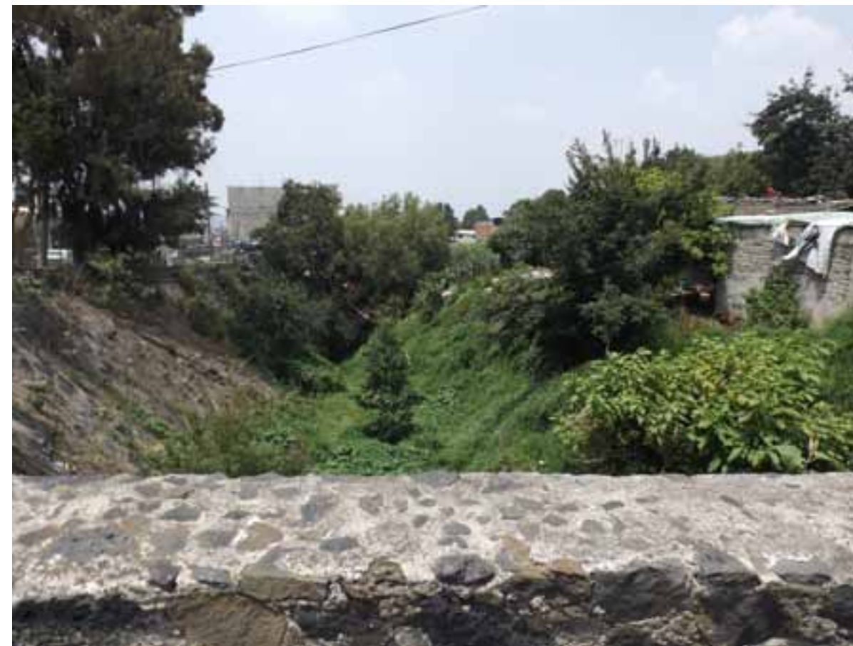
Figura VII.44. Barranca cubierta por material rocoso, sobre el cual se observa en la sección derecha una construcción semiconfinada.
