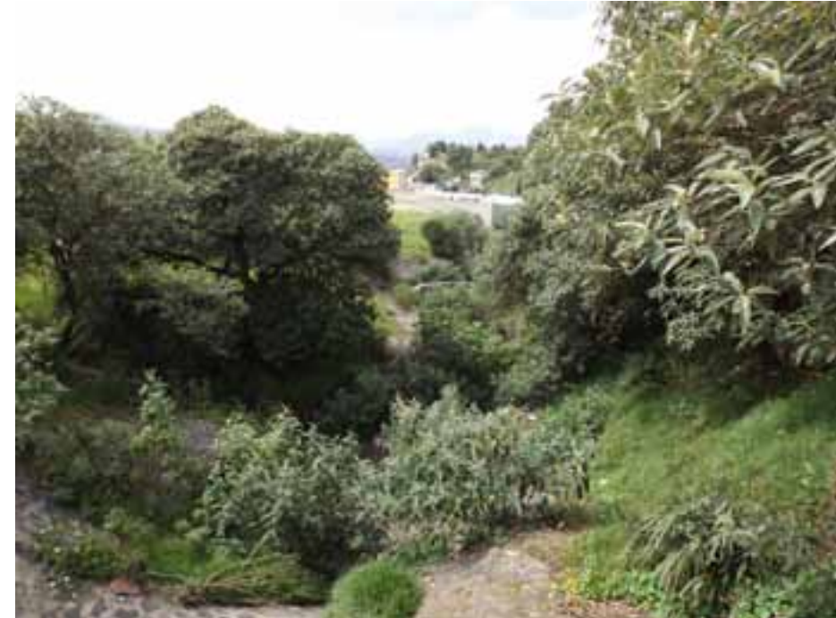
Figura VII.37. Flancos de la barranca actualmente cubierta de material enrocado, sobre el que se expone una vivienda susceptible al peligro.
