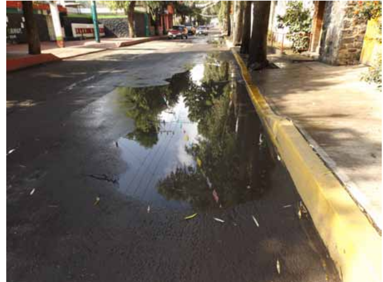
Figura VII.60. Encharcamiento de aproximadamente 3 cm de profundidad sobre el eje vial.
