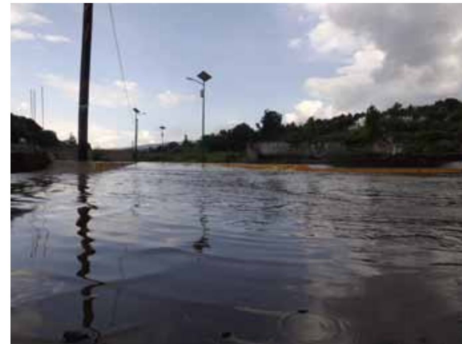
Figura VII.24. Vista panorámica del polígono de peligro "La Joya" en dónde se observan un nivel alto de saturación, generado a partir de un evento de baja intensidad, y la insuficiencia de la red de desagüe de la zona. Esta imagen representa el nivel mínimo al que se encuentra expuesta la zona.
