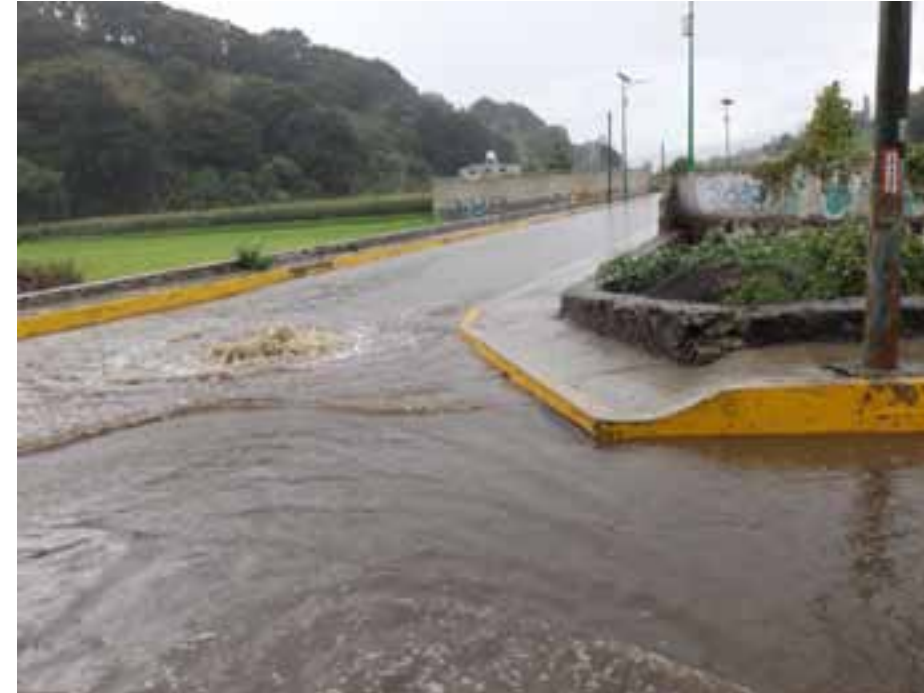
Figura VI.23. Vialidad inundada por un evento de baja intensidad, y saturación de la red de desagüe. Al izquierda, una obra para reducir la entrada de agua a la zona de cultivo.
