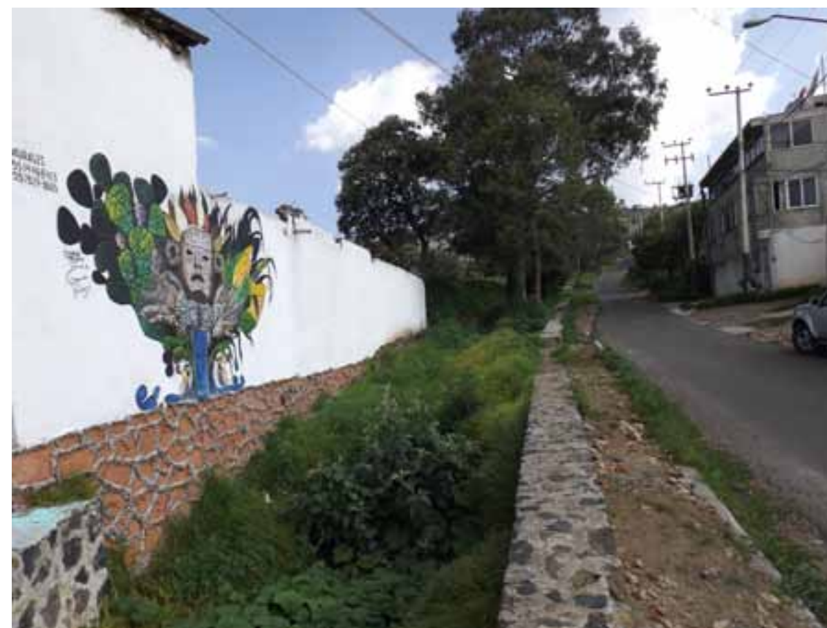
Figura VII.50. Muro de mampostería que divide a la zona de barranca con la vía de acceso. A la izquierda, una vivienda establecida dentro de los límites cauce natural de la barranca.
