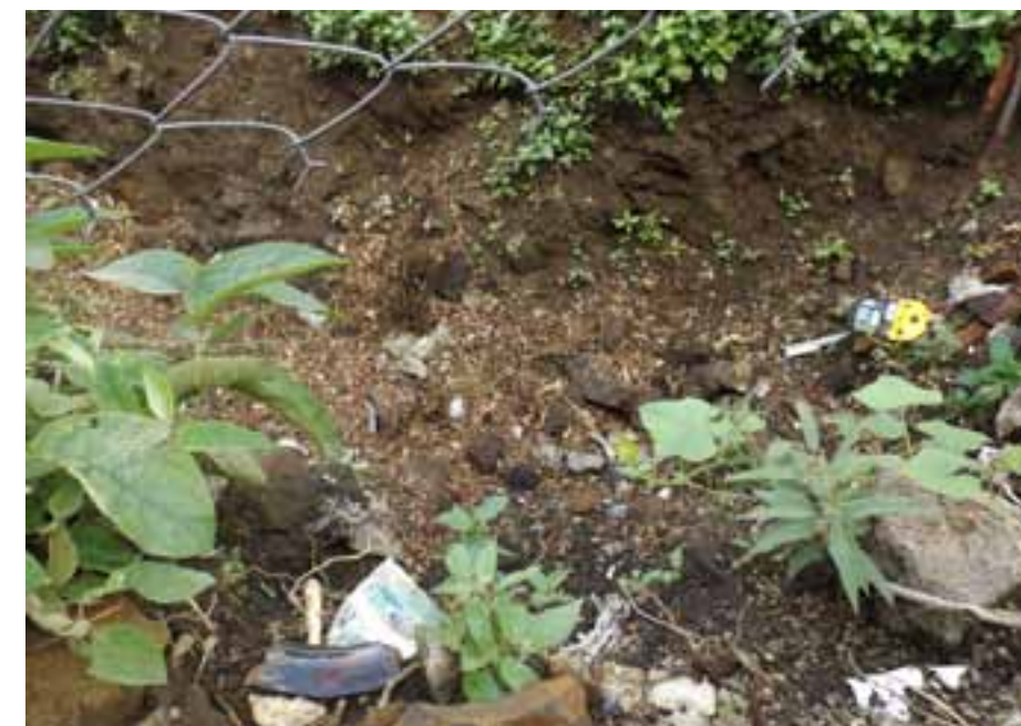
Figura VII.14. Zona de hundimiento, donde se expone material residual de suelo y rocas, además de depósitos de cascajo con cantidades de basura importantes, utilizadas para rellenar parcialmente el área afectada.
