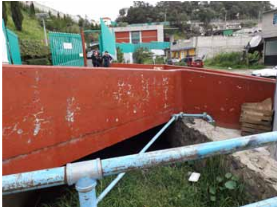
Figura VII.35. Sección del cauce natural de la barranca que es confinado por un dique de piedra, y sobre la misma obra se edifica la Preparatoria Emiliano Zapata.
