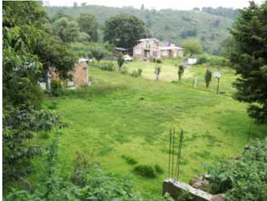
Figura VIII.5. Viviendas en riesgo por inundación en caso de avenida máxima.
