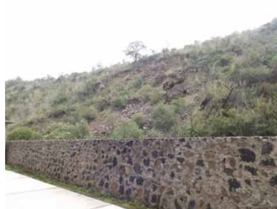
Figura VIII.11. Muro de mampostería con mortero para contener caída de bloques.
