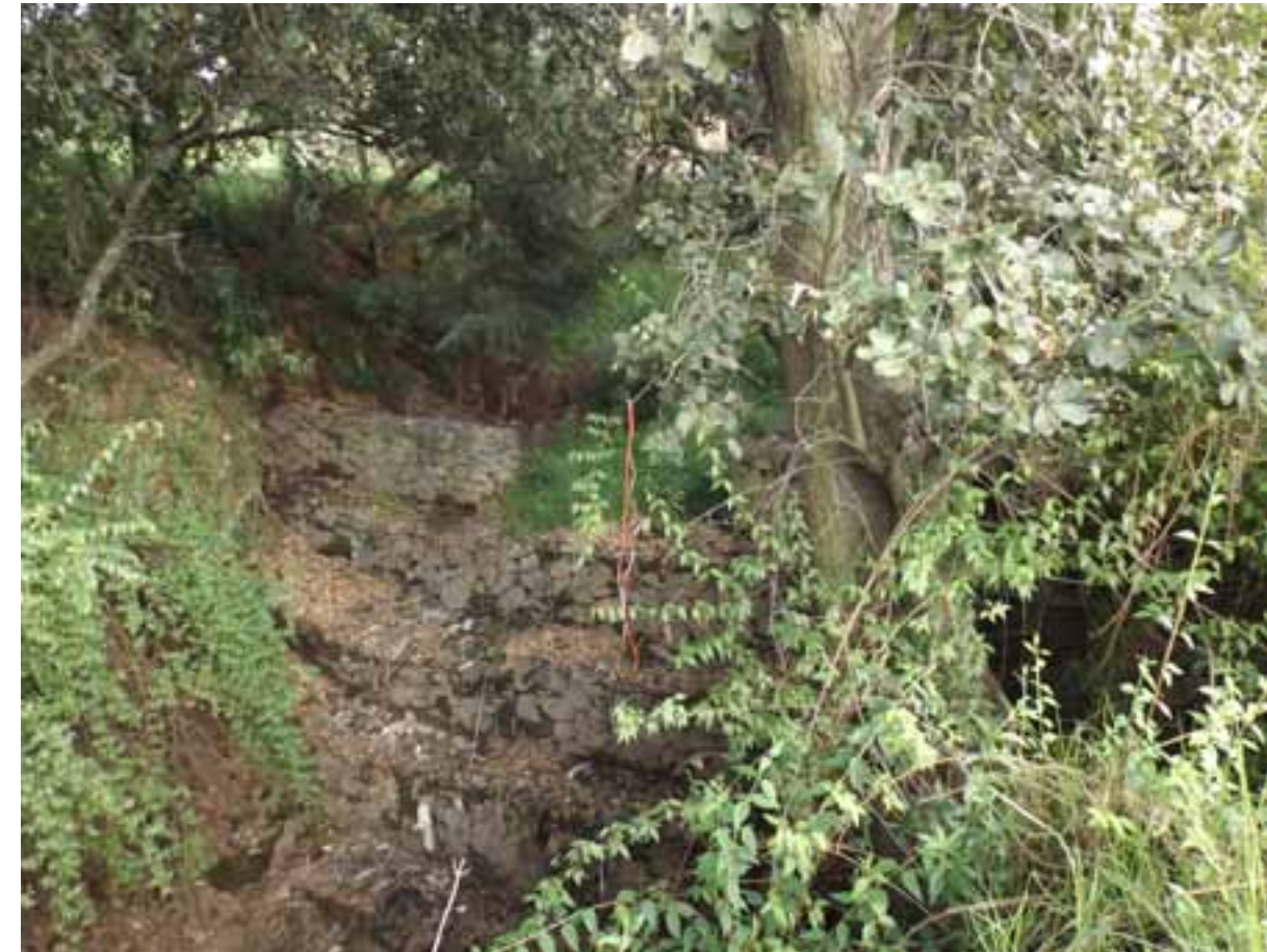
Figura VII.52. Obra de mitigación, que reduce el impacto de la escorrentía natural de la zona de barranca.
