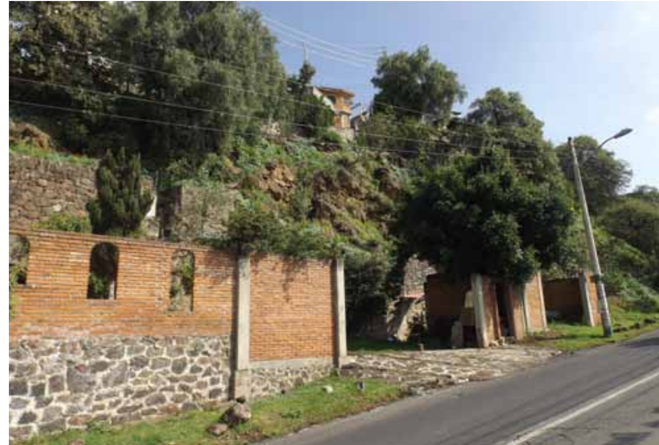
Figura VII.5. Vivienda localizada en la parte baja de la zona de caída de roca, esta área es representada por bloques de roca que alcanzan tamaños superiores a 50 cm.
