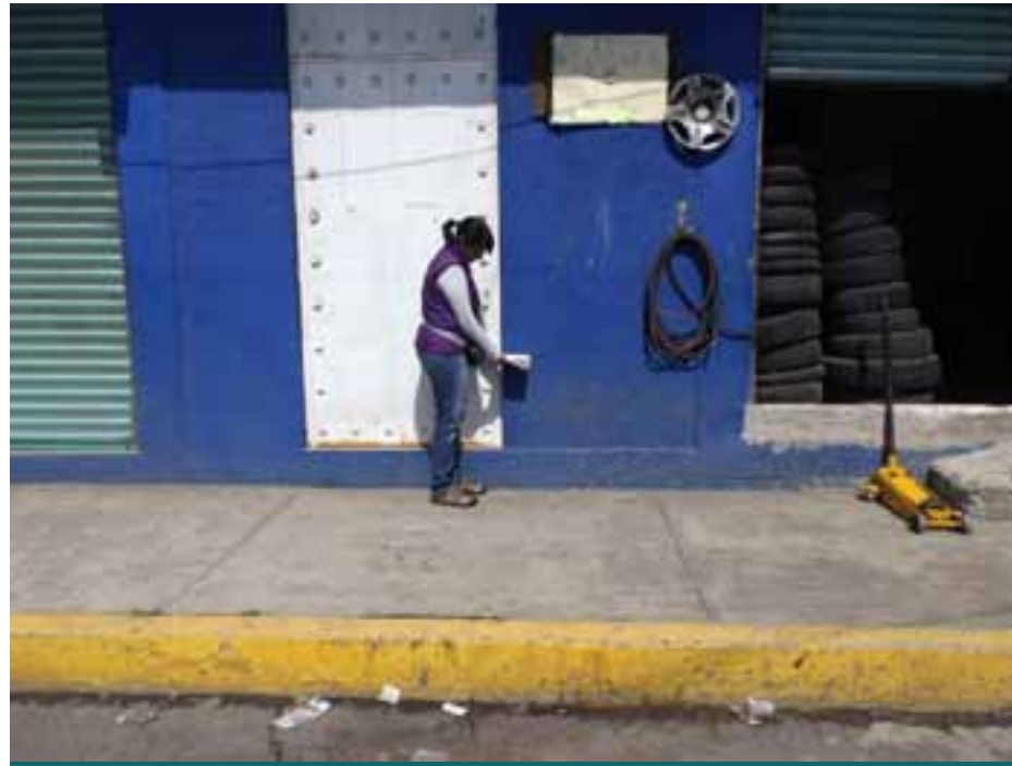
Figura VII.25. Muro con evidencia del nivel máximo de inundación (1.30 m de altura).
