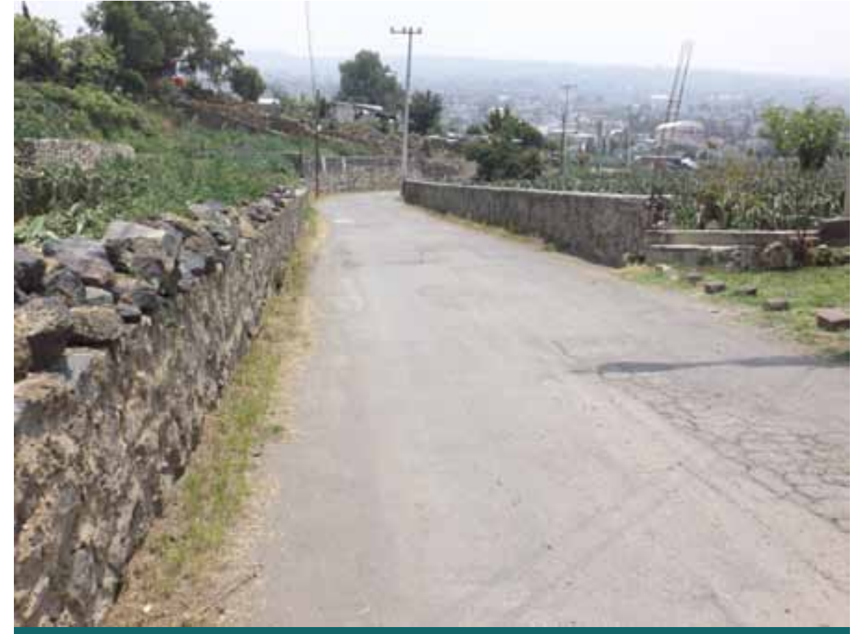
Figura VII.30. Se observan muros de aproximadamente 1 m de alto que separa el área de inundación con la zona de cultivo. A la derecha se puede observar la ausencia de este mismo muro debido a que en esta sección fue derribado para usar este espacio como desagüe.
