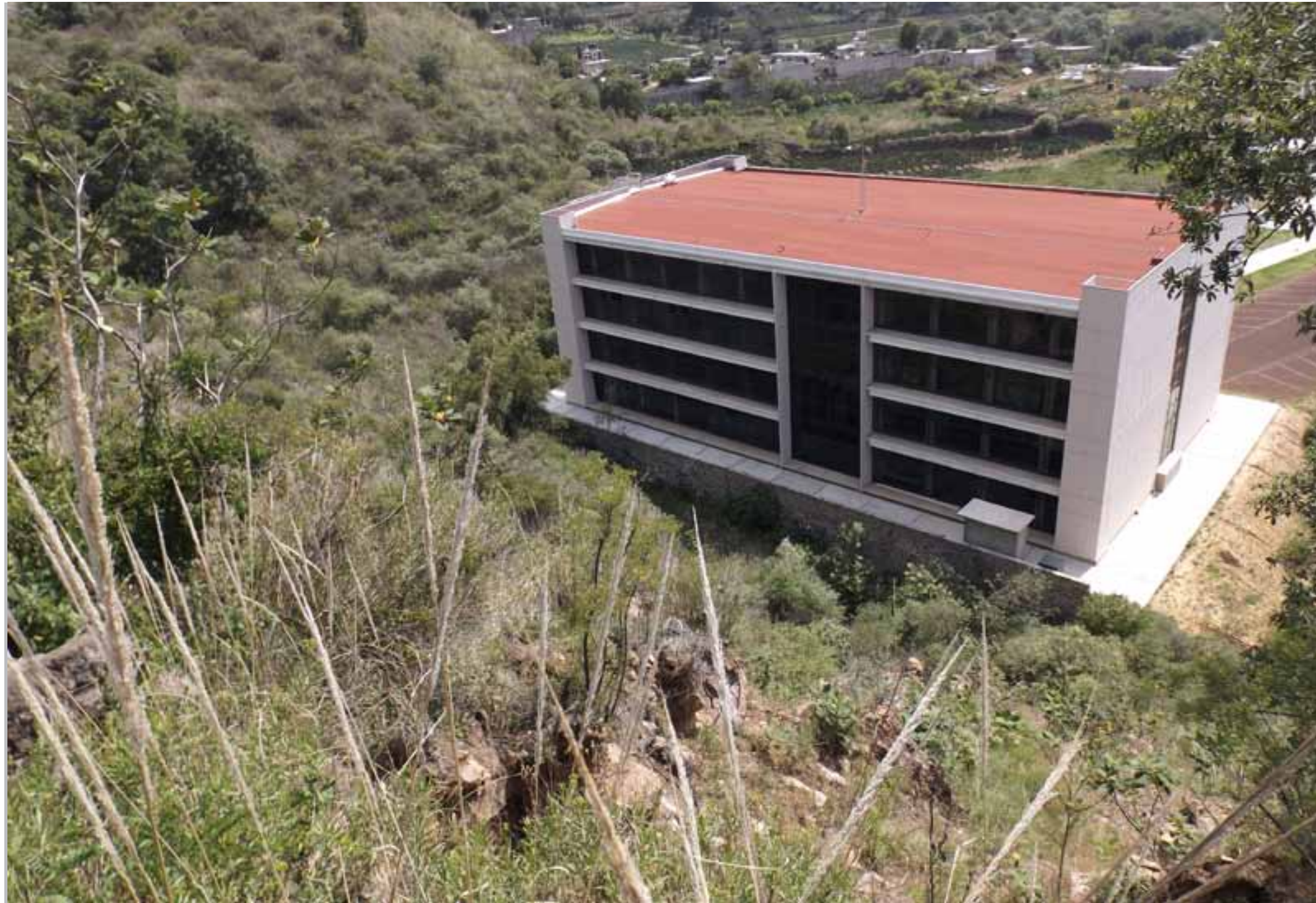
Figura VII.3. Vista superior del talud, al lado izquierda de la imagen se observan rocas de basalto, y al fondo una de las edificaciones del Tecnológico, por debajo de ella se puede apreciar un muro de contención.
