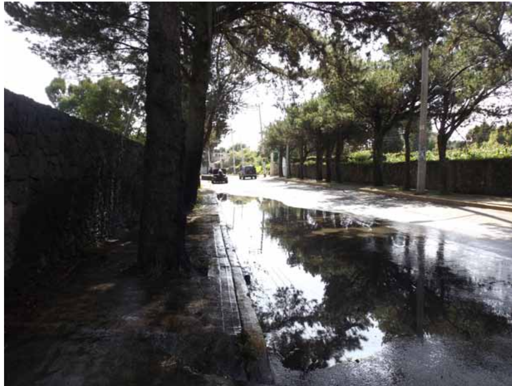
Figura VII.57. Zona de encharcamiento sobre el eje vial, el nivel del agua acumulada es de 6 cm de altura.
