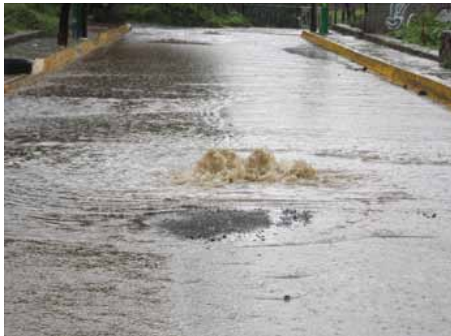
Figura VII.22. Insuficiencia de la red de drenaje ante la escorrentía de una lluvia de baja intensidad.
