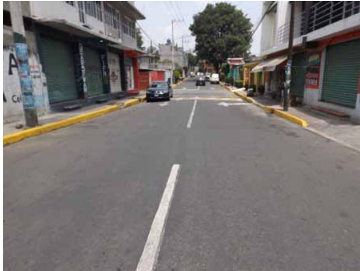
Figura VII.31. Vista panorámica del polígono de inundación Avenida España. En la imagen también se observan en los extremos algunos locales que presentan un escalón sobre su entrada, esta implementación es utilizada para impedir la entrada del agua en temporadas de lluvia.
