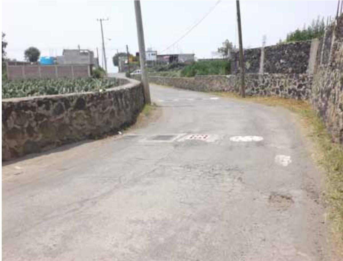
Figura VII.29. Vista panorámica del área afectada por el fenómeno de inundación y sistemas de alcantarillado presentes en la zona.
