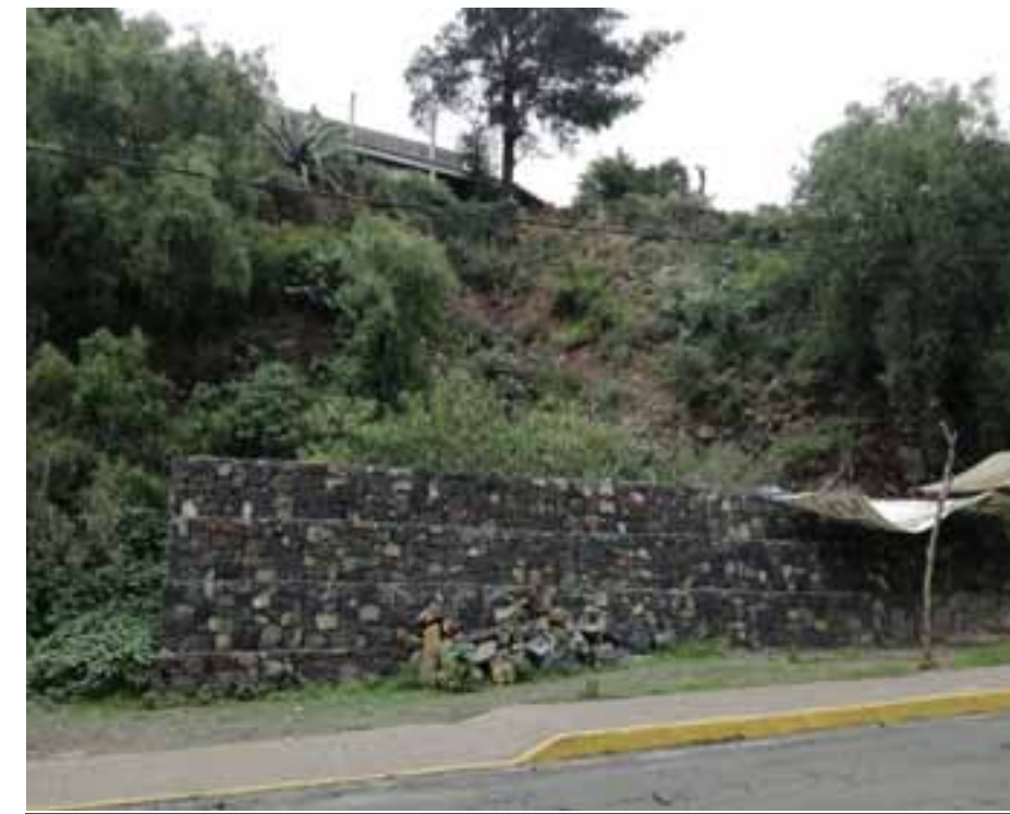
Figura VIII.8. Muro tipo gavión para contener caída de bloques hacia vialidad.
