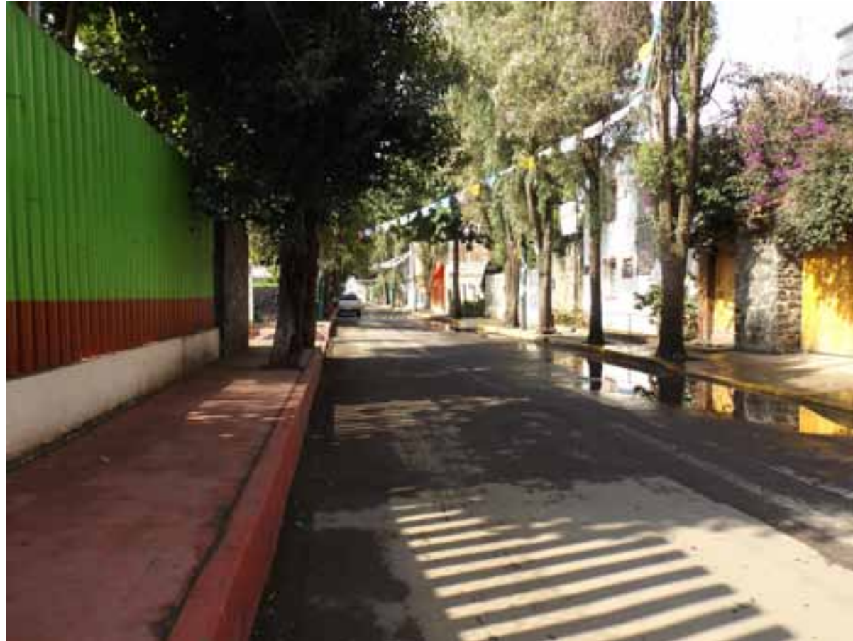
Figura VII.59. Avenida Cuauhtémoc con encharcamiento generado por una precipitación de baja intensidad.
