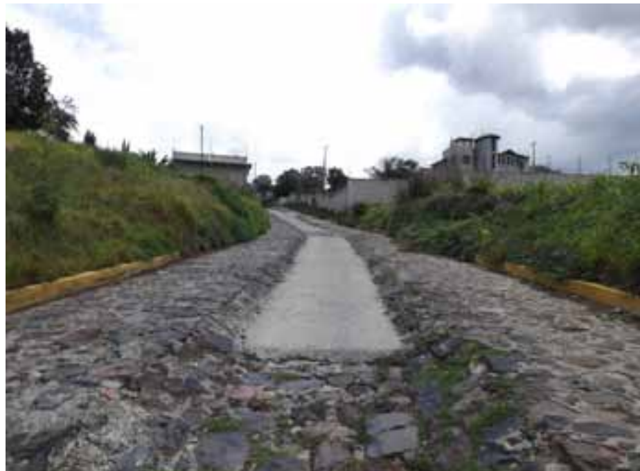
Figura VII.36. Cuneta de un metro de ancho, que recorre la calle Agustín Melgar.
