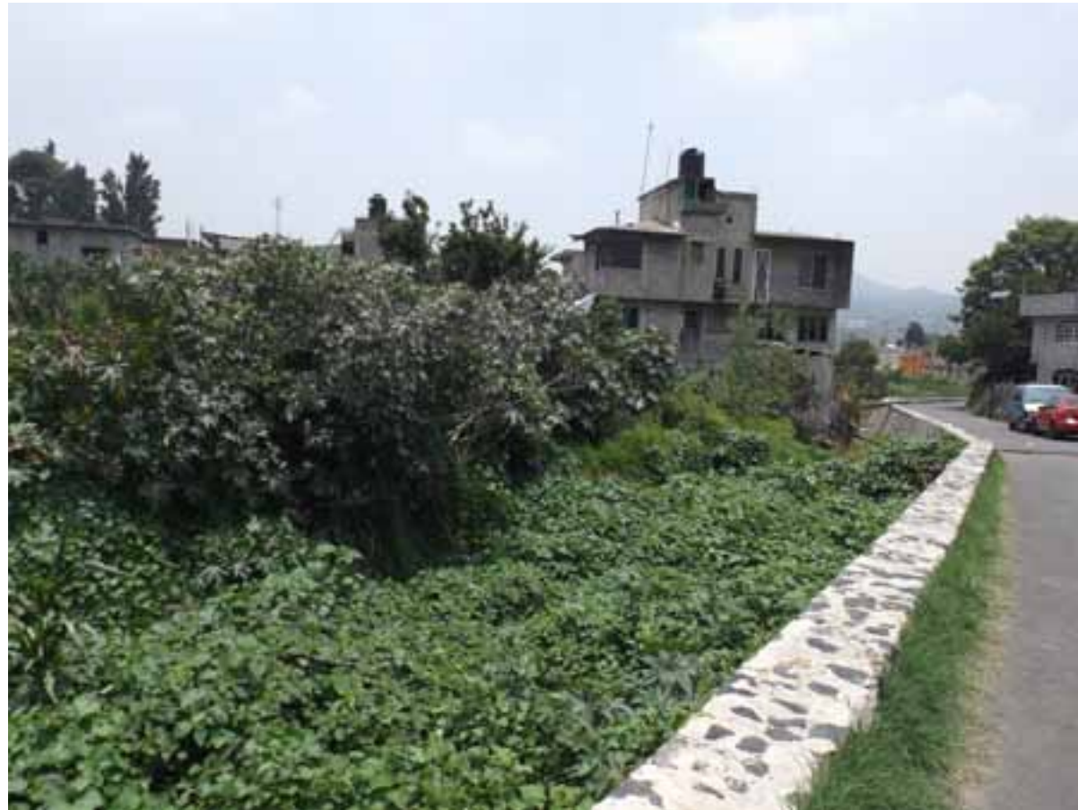
Figura VII.42. Barranca Tecoxpa, sobre la cual se observan construcciones irregulares y algunas obras que delimitan a la barranca.
